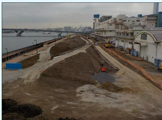
園路を整備しています。（四丁目）
