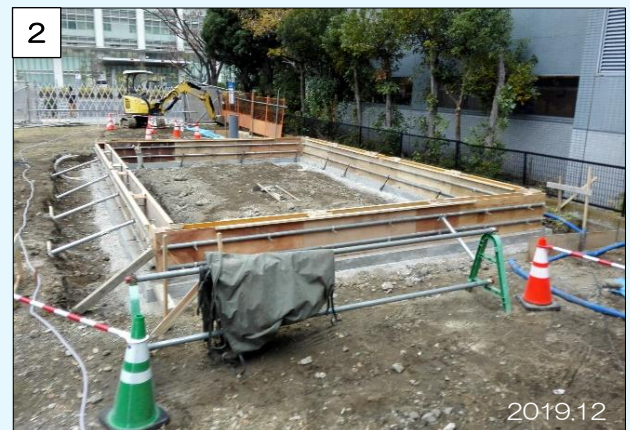
展示施設の基礎工事状況
